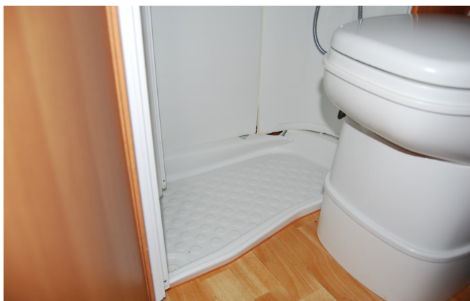
Bruch der Duschkabine und des Deckenventilators.
